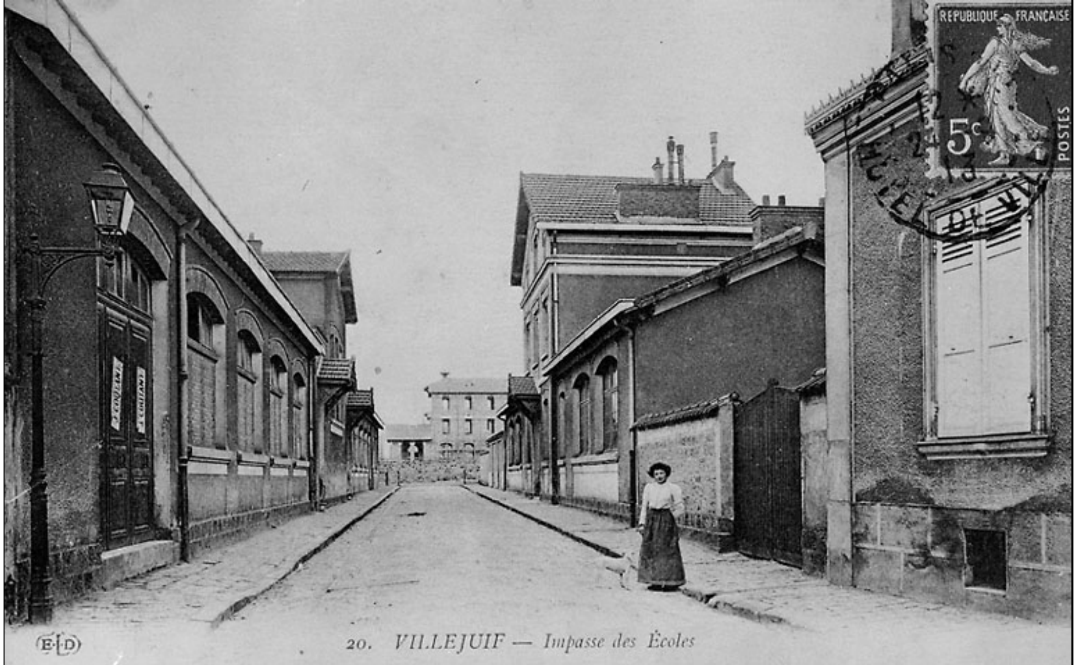
4 avenue Paul Vaillant Couturier Groupe scolaire du Centre, fin XIXème siècle
