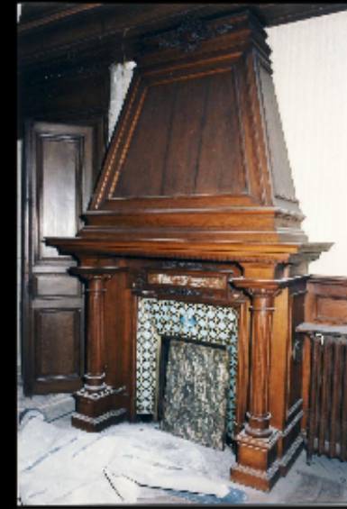
Cheminée située au premier étage du ceps central de l'hôtel.
