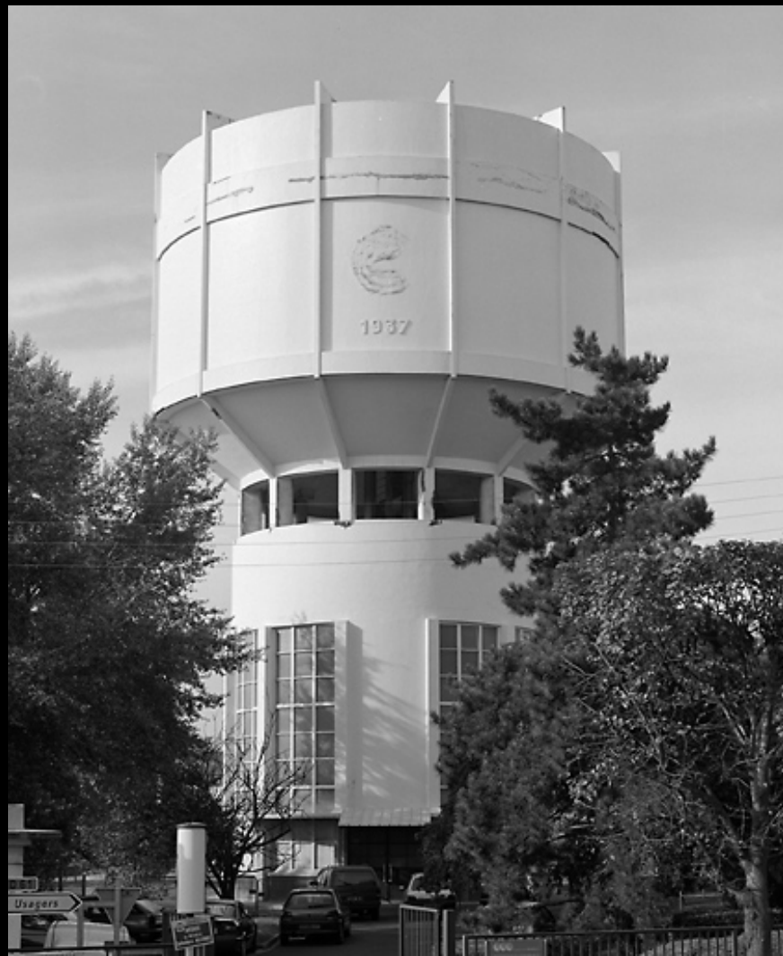
Château d'eau, 1 rue du Président Allende, XXème siècle
